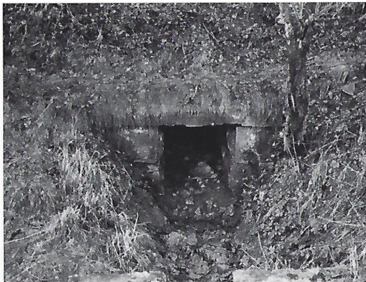
*Kleiner gemauerter Tunnel, sogenannter Düker, durch den Eisenbahndamm.*
